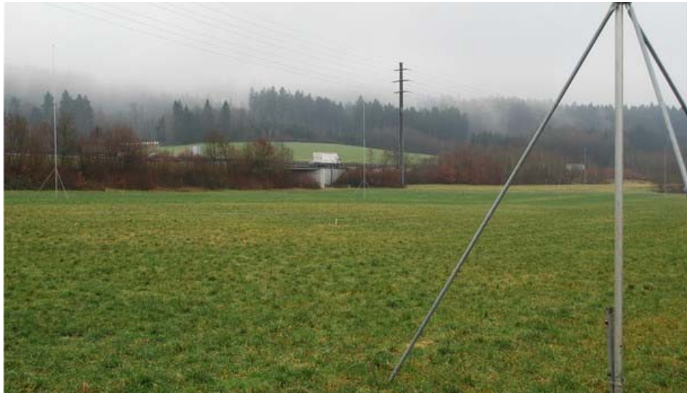
Die Bauprofile für das neue Logistikzentrum in Kölliken. lbr
